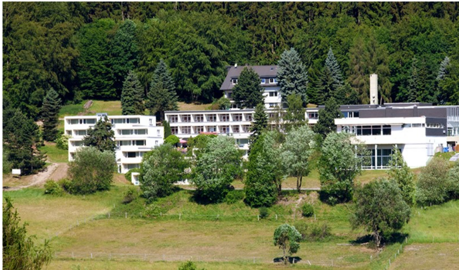
Familienferienstätte Dorfweil | Auf der Mauer 5 | 61389 Schmitten
